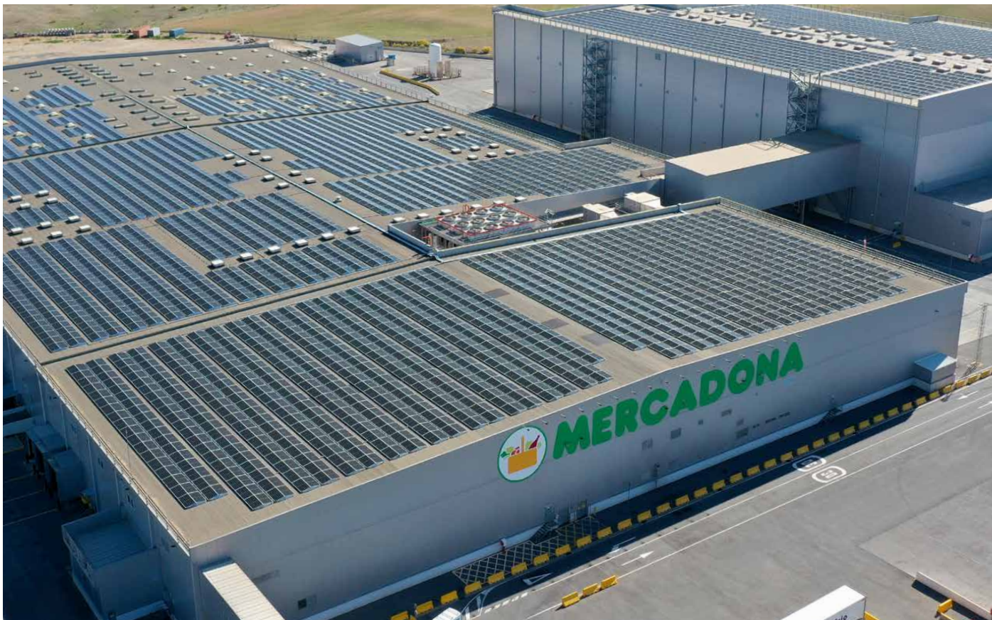
Guadixeko (Granada) bloke logistikoan instalatutako panel fotovoltaikoak.
