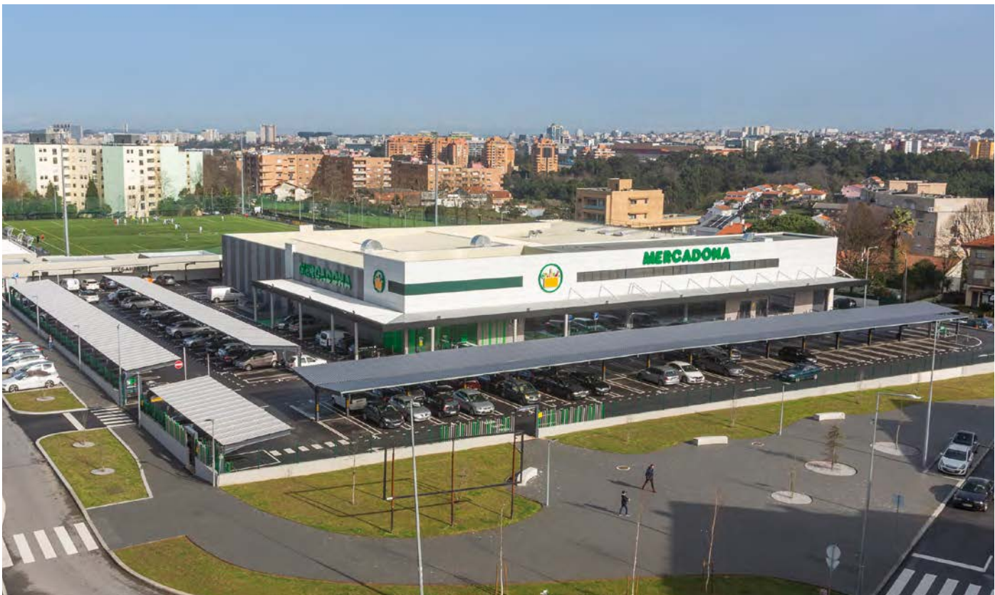
Exterior del supermercado de Canidelo en Vila Nova de Gaia, Porto, primera apertura de Mercadona en Portugal, e instalaciones del Sport Clube de Canidelo.
