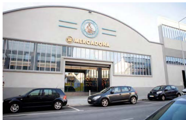
Exterior del supermercado de Sousa Aroso en Matosinhos, Porto, donde la compañía ha restaurado y mantenido la fachada y la chimenea de la antigua Fábrica de Conservas Vasco da Gama.
