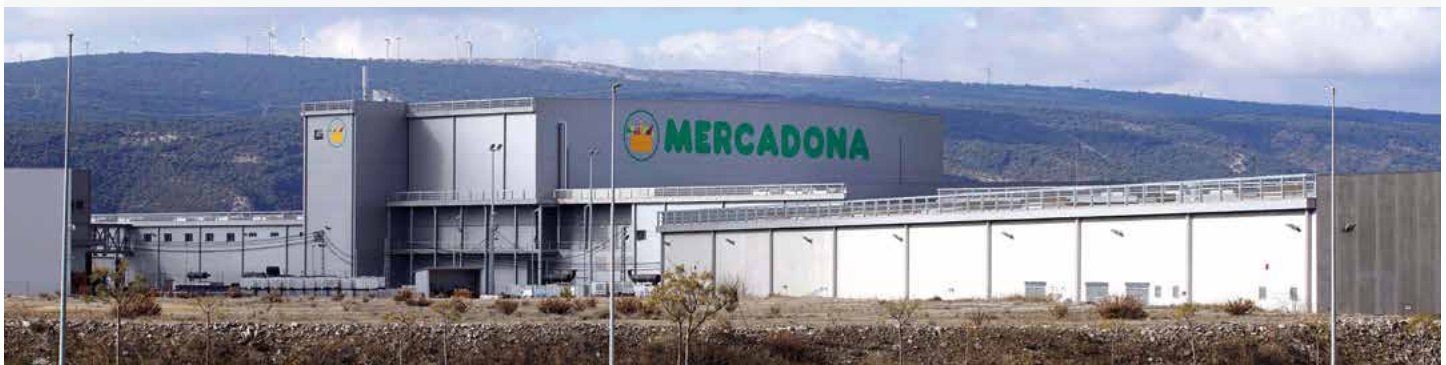
Bloque logístico de Vitoria-Gasteiz, Araba/Álava, en construcción.
