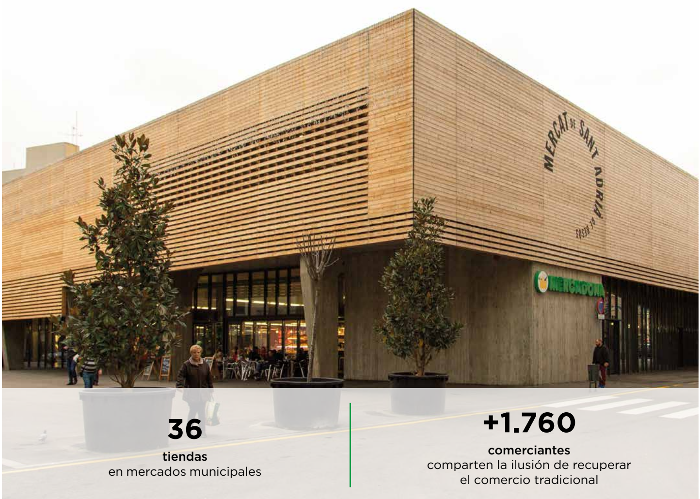
Fachada del supermercado en el Mercat Municipal de Sant Adrià de Besós, Barcelona.
