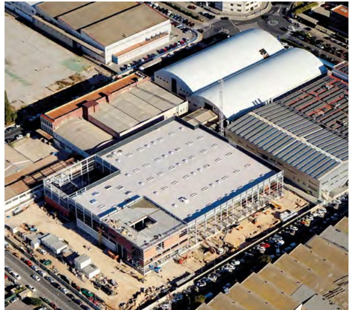
Fotografia aèria de les obres de construcció del futur centre de distribució de compra online al polígon Vara de Quart, València.
